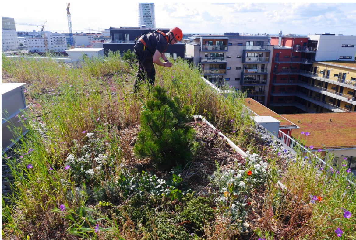
Foto: Inspektion och skötsel på gång på taket på MKBs fastighet på kvarteret Koggen. Västra Hamnen, Malmö. (Fotograf: Jonatan Malmberg, Scandinavian Green Roof Institute)
